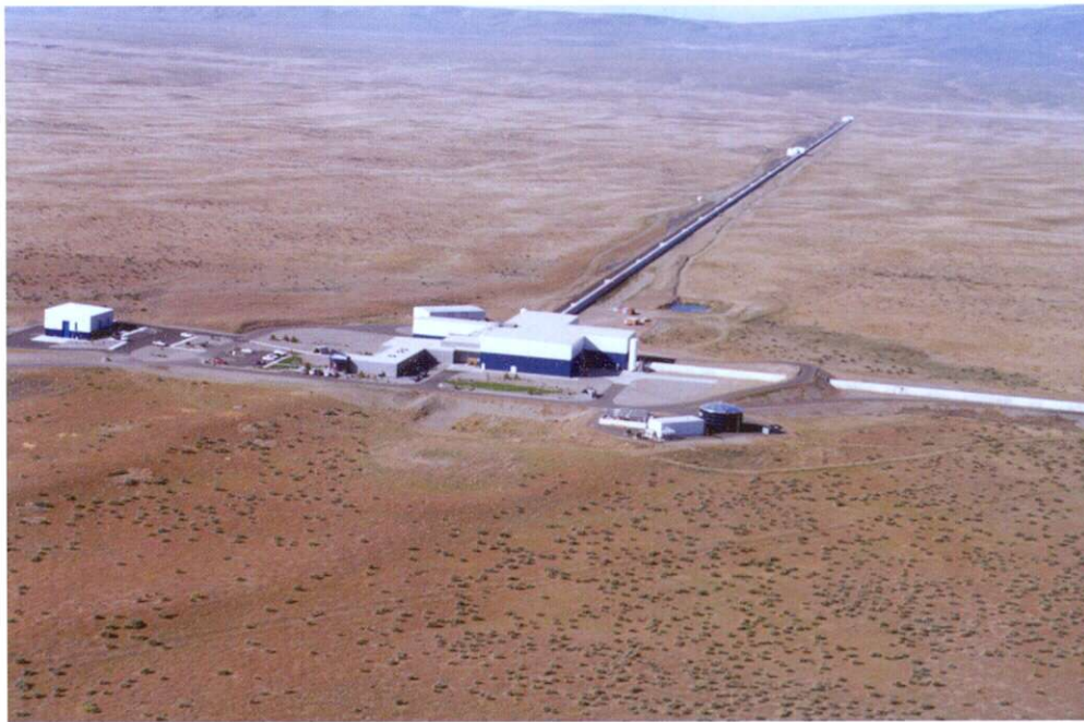
Abb. 9: Der LIGO Gravitationswellendetektor in Hanford im Bundesstaat Washington, USA. Man erkennt die beiden senkrecht zueinander angeordneten, vier Kilometer langen Arme des Interferometers. Der Laser, der Strahlteiler und die Nachweisapparatur befinden sich in dem Gebäude im Vordergrund. Ein zweiter, ähnlicher Detektor befindet sich in Livingston im Bundesstaat Louisiana, USA.
